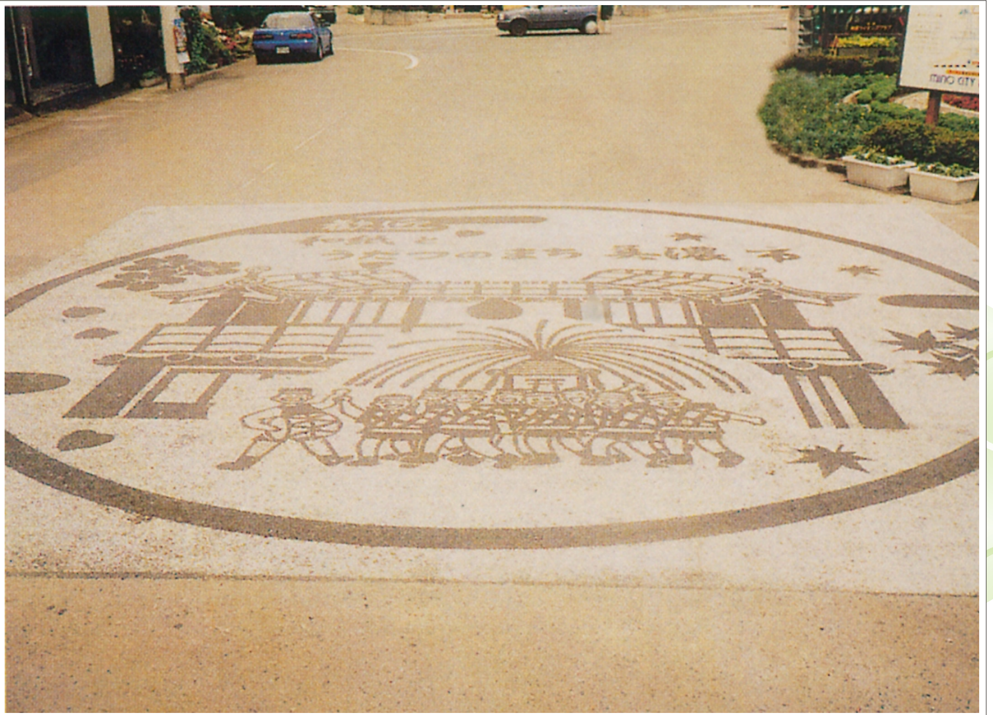
美濃市駅前舗装工事
